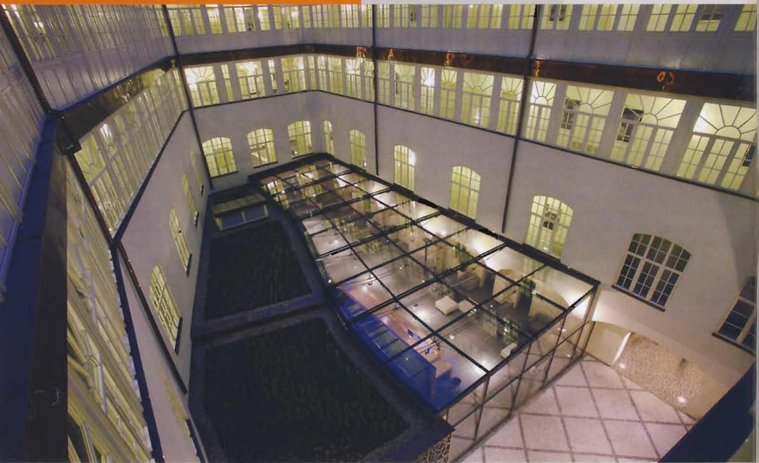
▲ Pohled na atypické skleněné zastřešení atria domu U Zlatého anděla
