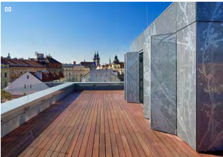
00 > Střešní terasa – v této části se části fasád při otevření skládají
